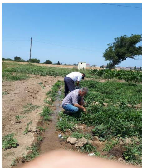
Note: Piping phase 06.07. 2021
